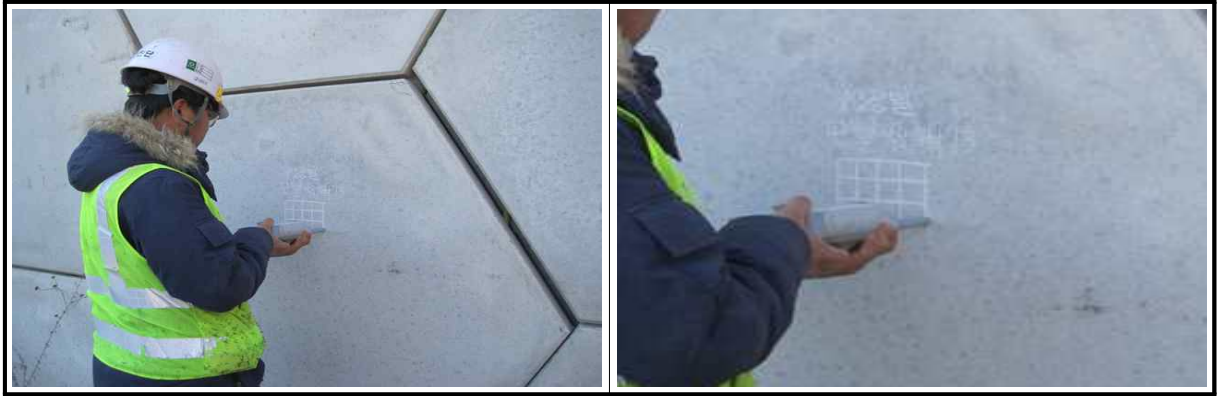
【그림 13.3.6】 슈미트해머를 이용한 반발경도시험 전경
